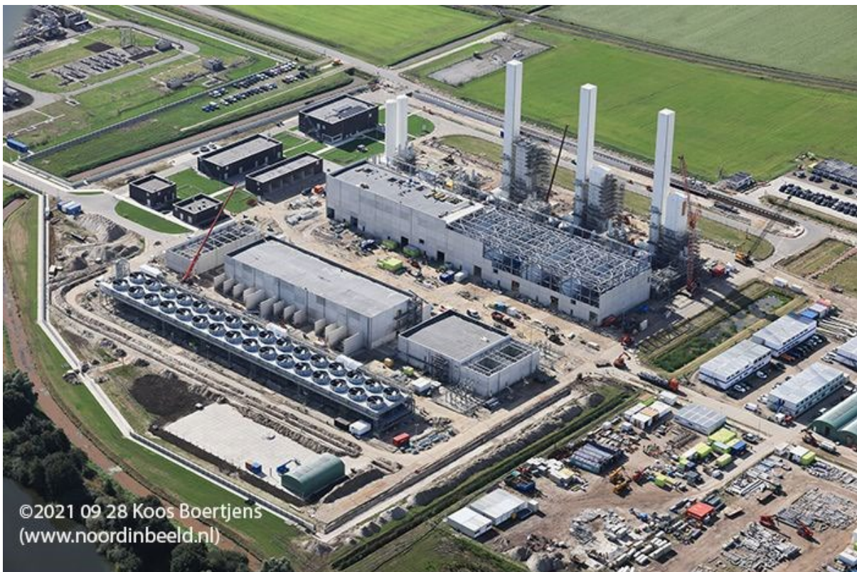
Foto des Baus der Stickstoffanlage Gasunie in Zuidbroek.
